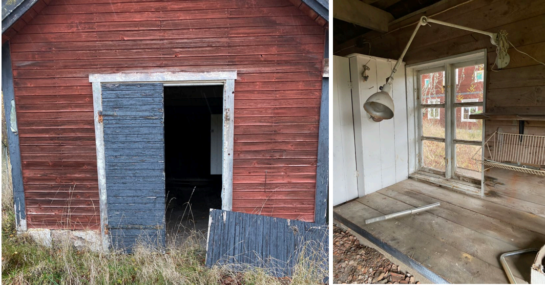
Figur 9. Skjulet som syns i fotografiet i Figur 8 fast framifrån samt detaljer inne i i byggnaden. Foto 2020-10-28, Gren Consulting AB.
