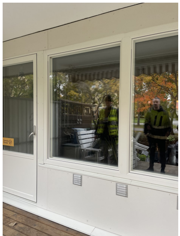
Bild från besiktning av de nya fönstren.
