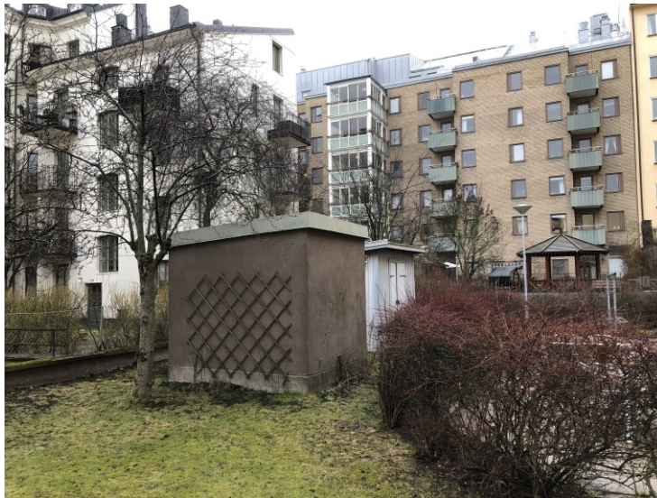
Del av innergården med nödutgång från garage samt förråd. Foto: Stadsbyggnadskontoret.
