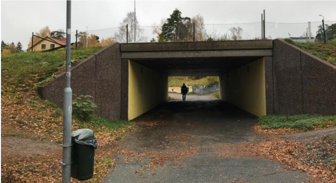
Figur 4. Befintlig bro över gång- och cykelväg vid Grisslinge vårdshus, foto taget söder om väg 222 mot norr.
