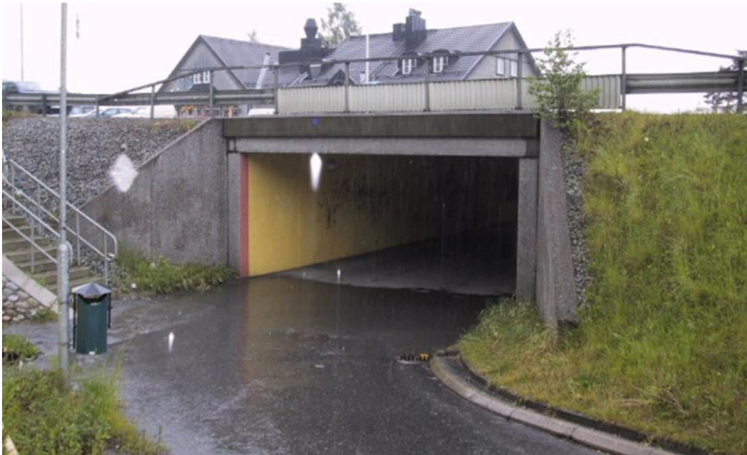
Figur 5. Befintlig bro över gång- och cykelväg vid Grisslinge Vårdshus. Foto taget norr om väg 222 med riktning söderut. Foto från broförvaltningssystemet BaTMan
